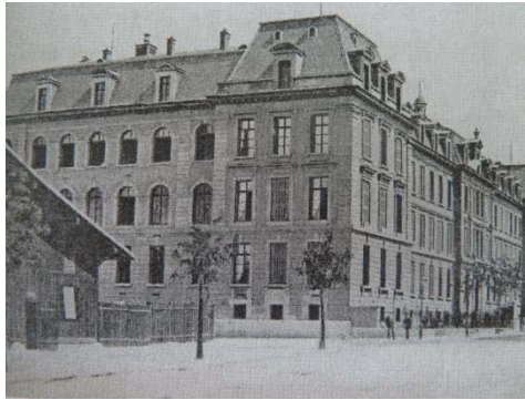
Hauptfront des alten Spitalgebäudes, Klingenbergstrasse, Basel
