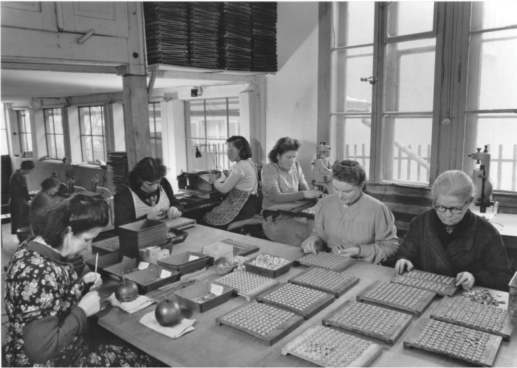
Abb. 5: 1939-45: Knopfmontage in der Zeit des zweiten Weltkriegs. Im Vordergrund Vorbereitungsarbeiten. Rechts in Bild zwei Arbeiterinnen beim Ausrichten von Knopfschalen und Rückteile. Sehr schön zu erkennen sind die Brettchen zum Ausrichten. Vgl. auch Abb. 7.
