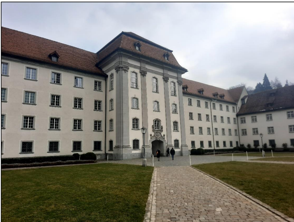
Abb. 5: Das Regierungsbau von St. Gallen; baugeschichtlich aufgeteilt in die Neue Pfalz, mit dem Kantonsratssaal im oberen Stock des Mittelrisalits, und die Alte Pfalz ganz rechts.
